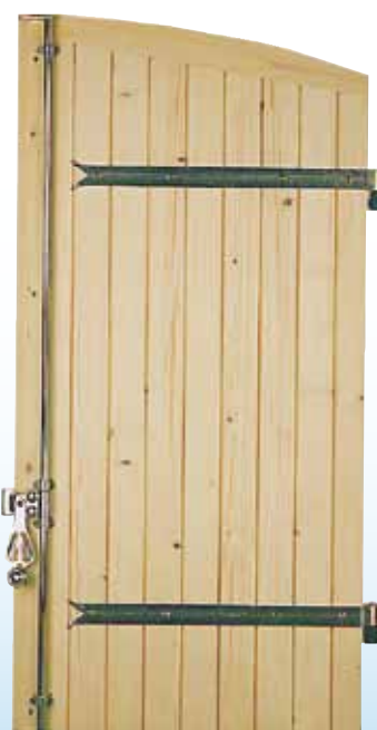
Pentures et contre-pentures avec cintre découpé sur emboîture en biais
