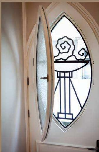
Les grilles d'origine ont été démontées, et transférées dans les usines Bel'M. Les formes de la porte et les moulures de vitrage ont été prévues spécifiquement pour recevoir ces grilles. Après une phase de restauration (sablage et laquage), assurée par nos soins, elles ont été installées, en usine, sur la nouvelle porte.
